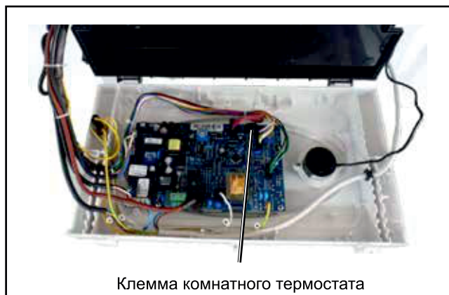
Рис. Подключение комнатного термостата
